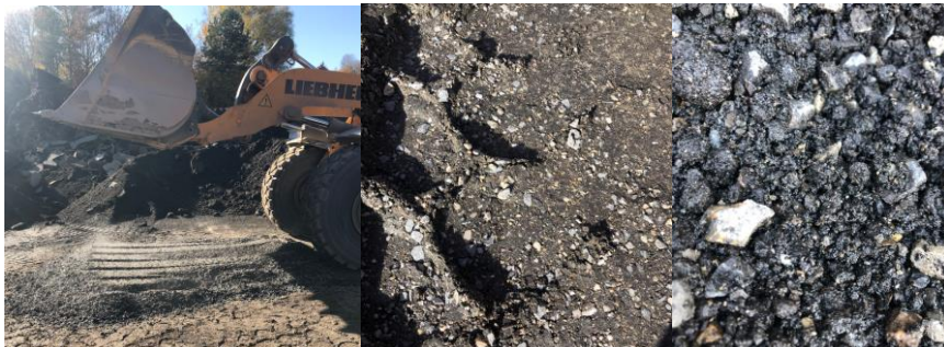
Fig. 50 Aspect de l'enrobé à froid fabriqué à la mousse
