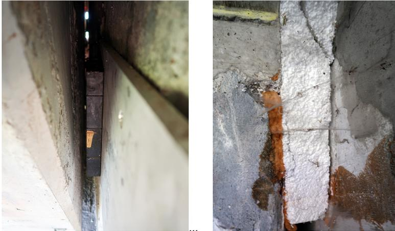
**Abb. 73** Elastomerplatte als Puffer (links) und Polystyrol-Einlage zwischen Brückenträger und Widerlager (rechts).
