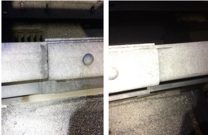
**Abb. 120** Schrammspuren an den Stössen der Leitplanken.
