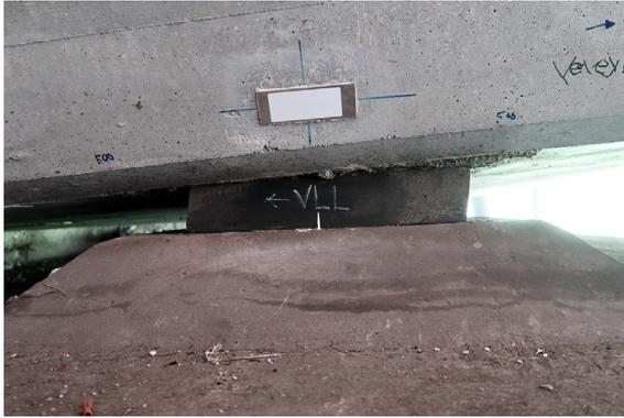
**Abb. 111** Elastomerlager am Widerlager Vevey.
