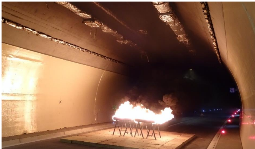
Abb. 76 Schutz der Tunnelausrüstung während eines Brandversuchs
