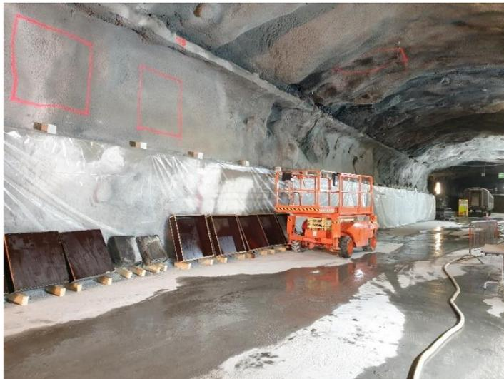
**Abb.11** Aufbau Spritzkisten und Hebebühne
