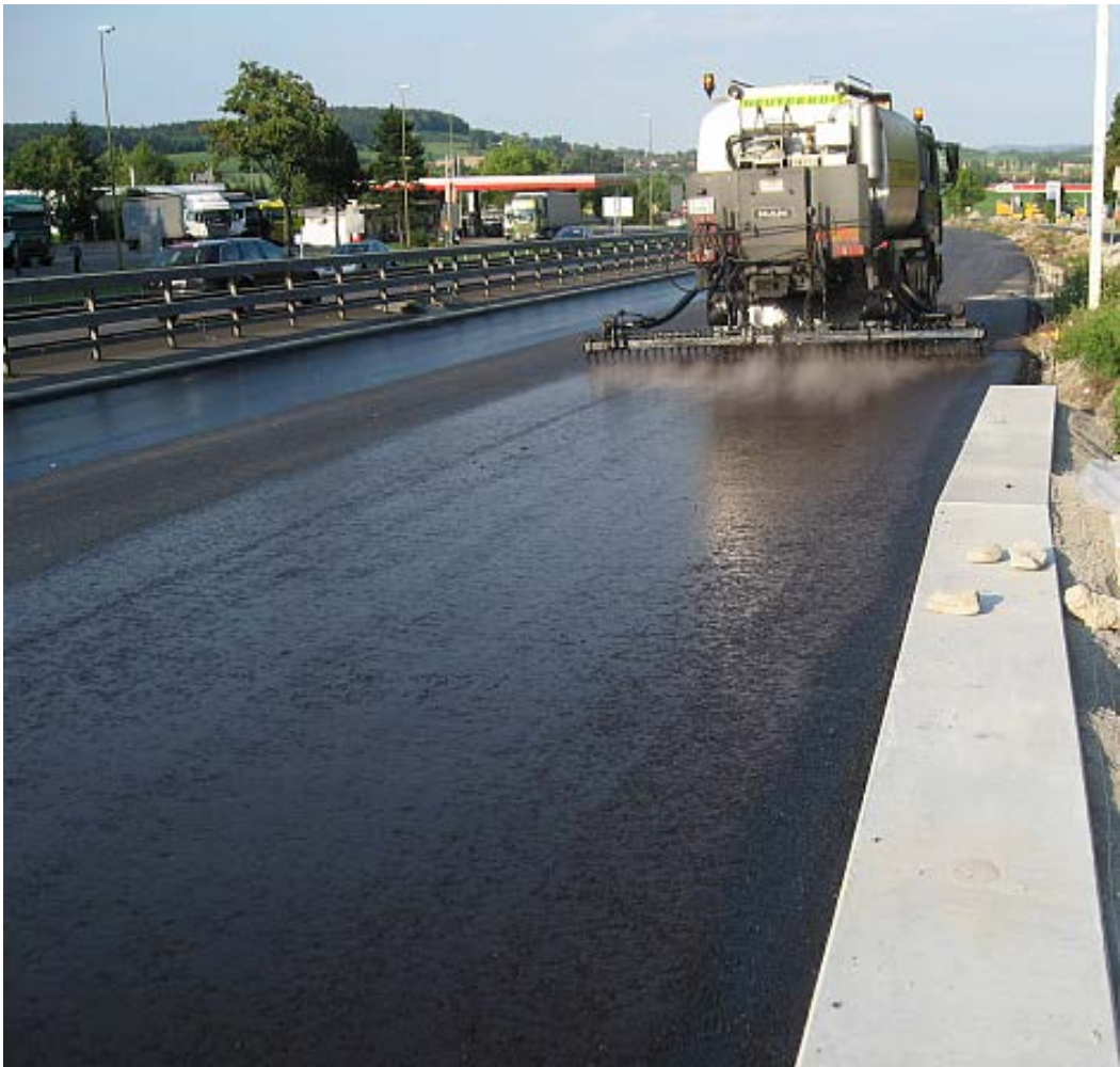
Abb. 40 Applikation des Haftklebers auf AC EME 22 C2
