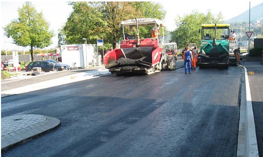
Abb. 29 Oberfläche beim DeckBelageinbau.
