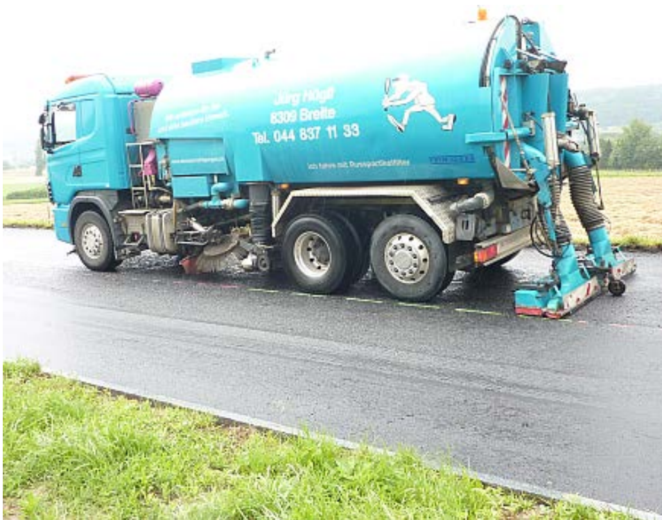
Abb. 14 Absaugen der Feuchtigkeit.
