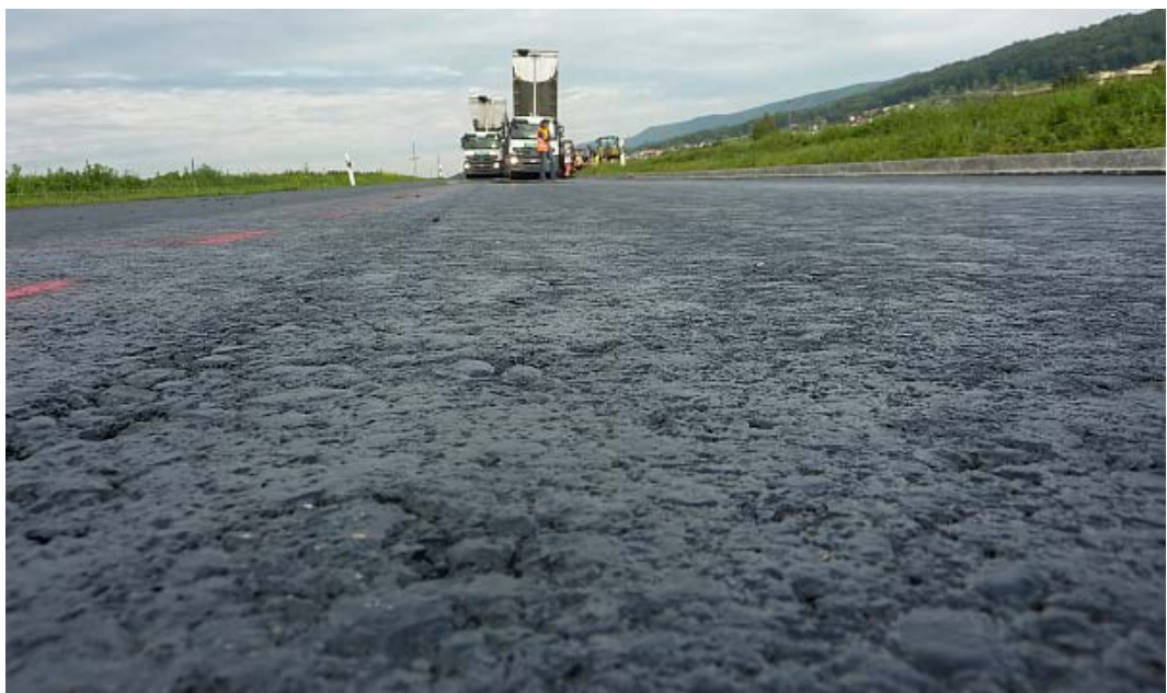
Abb. 19 Einbau des Deckbelages auf AC EME 22 C1 mit PmB.
