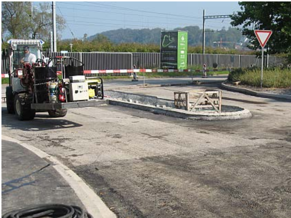
Abb. 27 Leicht verschmutzte Oberfläche vor Applikation der Bitumenemulsion
