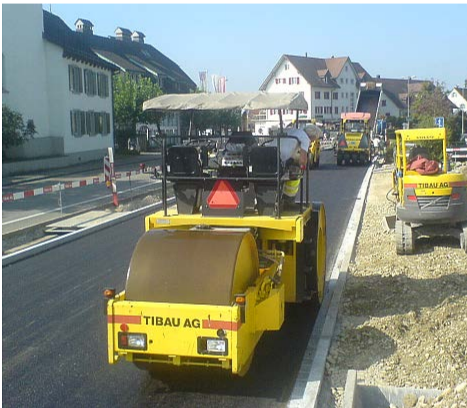
Abb. 32 Einbau der Binderschicht
