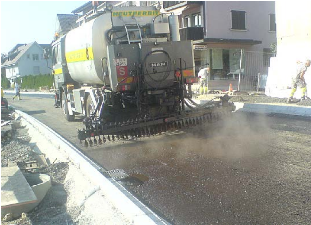
Abb. 30 Applikation der Bitumenemulsion auf die Fräsfläche
