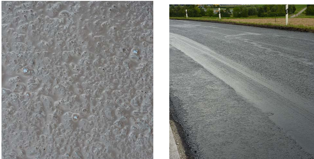
Abb.13 Haftkleber 400 g/m 2 während Brechvorgang (Detail) und gebrochener Haftkleber HCP auf Fräsfläche am Vorabend des Belageinbaus.
