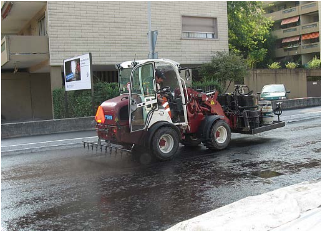
Abb. 28 Applikation der Bitumenemulsion mit Eigenkonstruktion.
