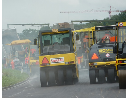
Abb. 16 Belageinbau mit ständigem Absaugen der Feuchtigkeit und Belageinbau.
