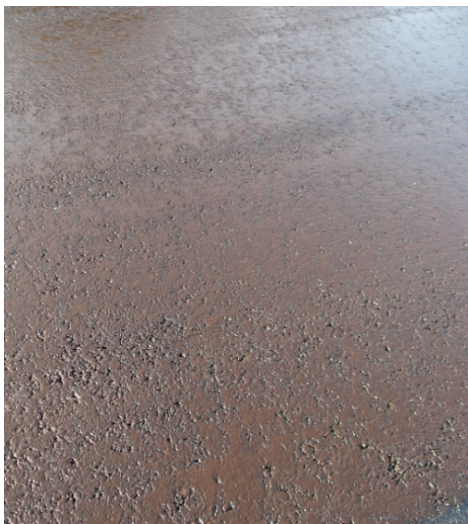
Abb. 24 Haftkleber: Brechvorgang nach 30 Sekunden.
