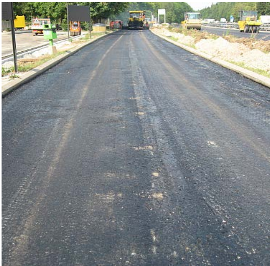
Abb. 47 Haftkleberoberfläche: sichtbarer Abtrag und Verschmutzung.
