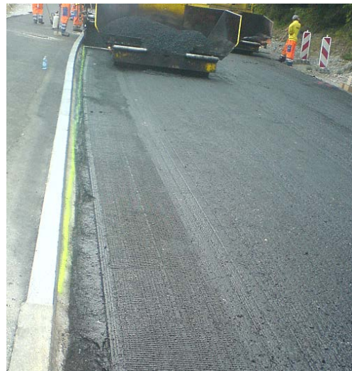
Abb. 21 Belageinbau Binderschicht: Haftkleber mit Randasphaltarmierung.
