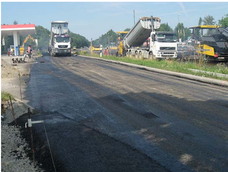
Abb. 49 Abtrag des Haftklebers auf gefrästen Oberflächen durch den Antransport des Belages.
