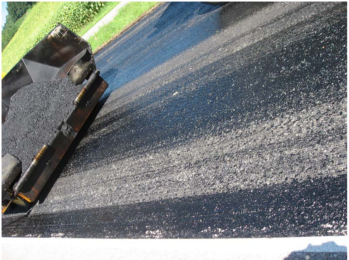
Abb. 5 Haftkleber auf Fräsfläche
