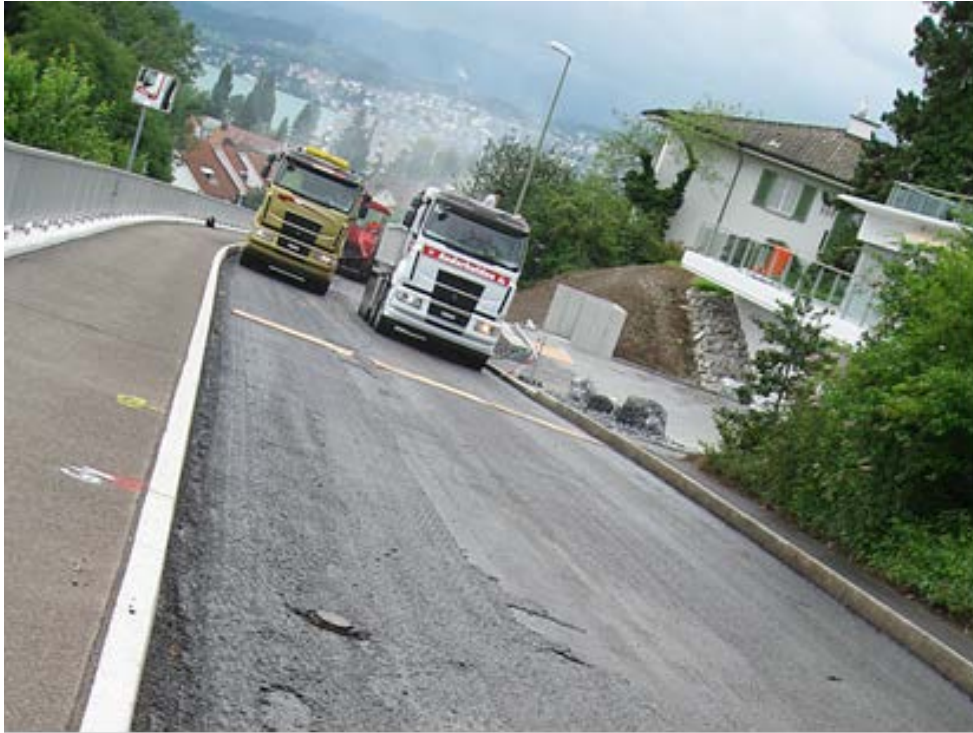
Abb. 4 Ansicht Fräsfläche nach Haftkleberauftrag
