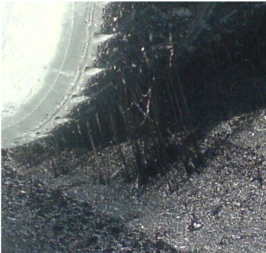
Abb. 39 Bitumenfäden beim Fertigerrad beim Einbau der Deckschicht.
