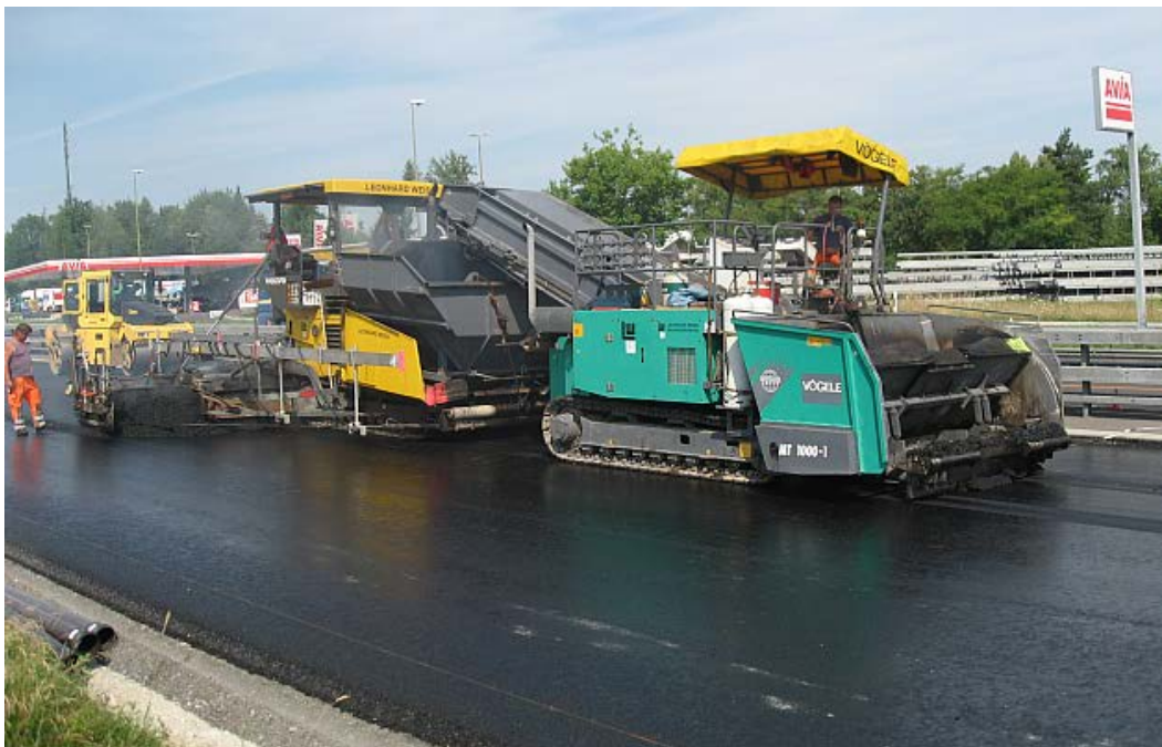
Abb. 42 Belageinbau AC EME 22 C1: Einbau mit Beschicker.
