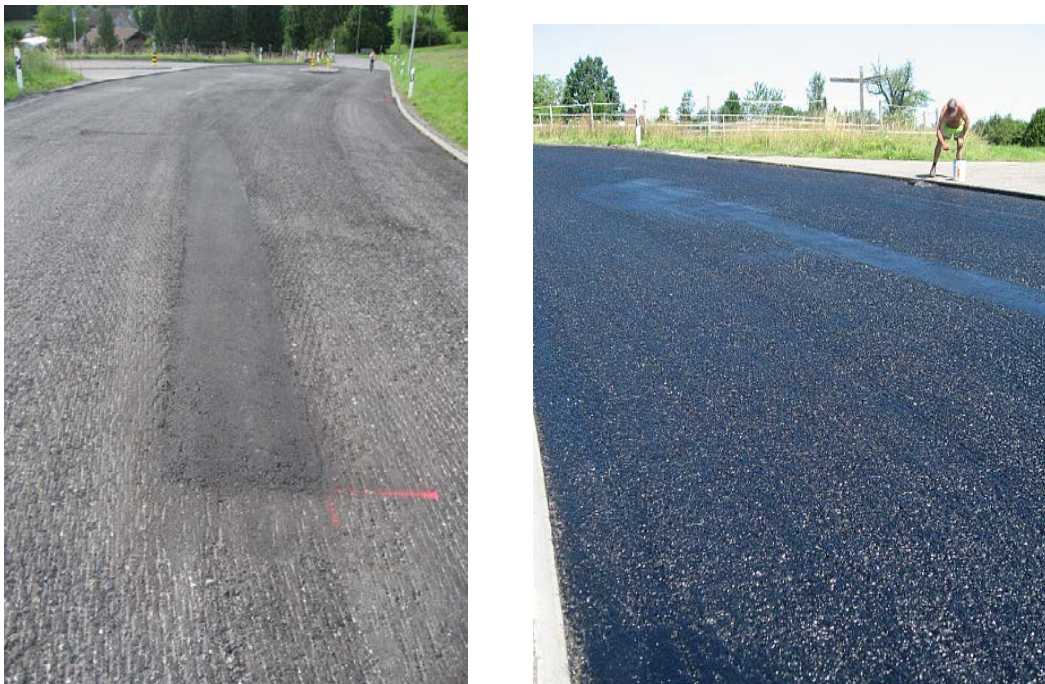
Abb. 12 Fräsfläche: Nach Reinigung (links), nach Haftkleberapplikation (rechts)
