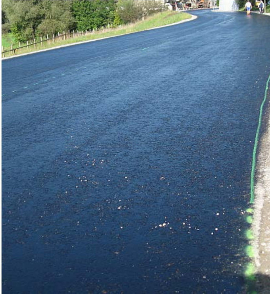
Abb.10 Gebrochener Haftkleber HCP nach rund 90 Minuten beim speziellen wellenförmigen Spritzbild.
