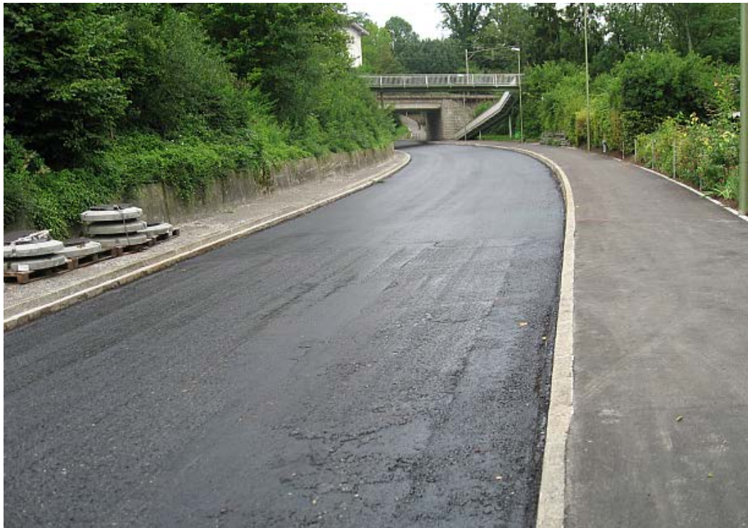
Abb. 3 Haftkleber auf Fräsfläche und Heissmischfundationsschicht.
