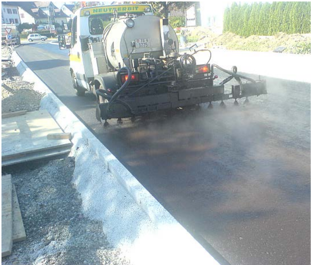
Abb. 33 Applikation des Haftklebers auf die abkühlende Binderschicht.
