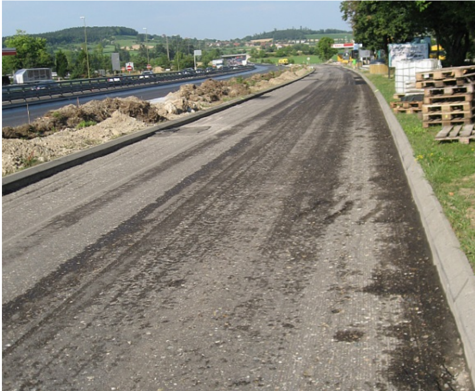
Abb. 44 Oberfläche nach Nasshochdruckreinigung.
