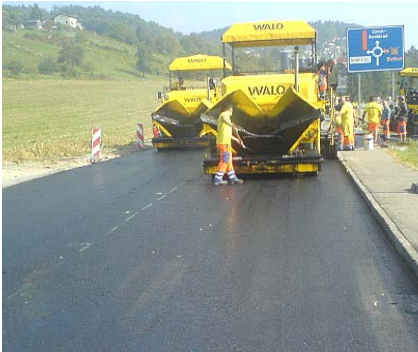
Abb. 22 Haftkleberoberfläche vor Einbau des Deckbelages
