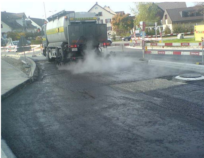
Abb. 35 Applikation des Haftklebers mit unfertigen Belagsstellen.
