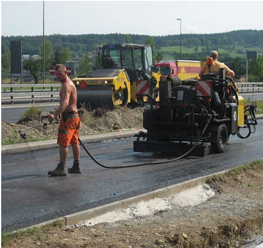
Abb. 48 Nachspritzen Abtrag- und Verschmutzungsflächen.
