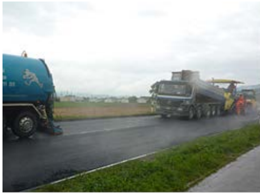
Abb. 16 Belageinbau mit ständigem Absaugen der Feuchtigkeit und Belageinbau.
