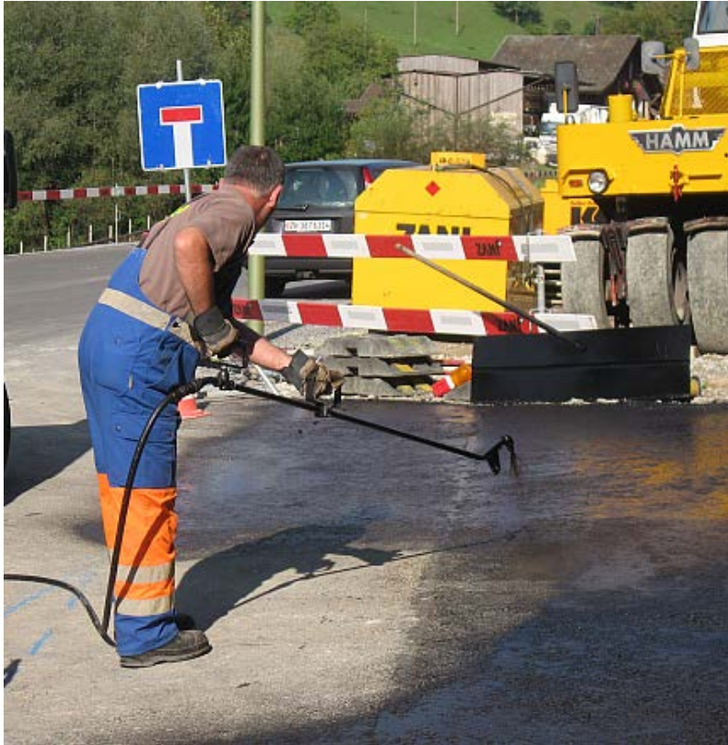
Abb.8 Applikation von Hand auf kleinem Bereich mit verschmutzter Unterlage.
