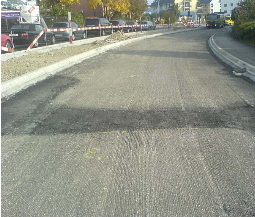
Abb. 34 Fräsfläche vor Applikation des Haftklebers.
