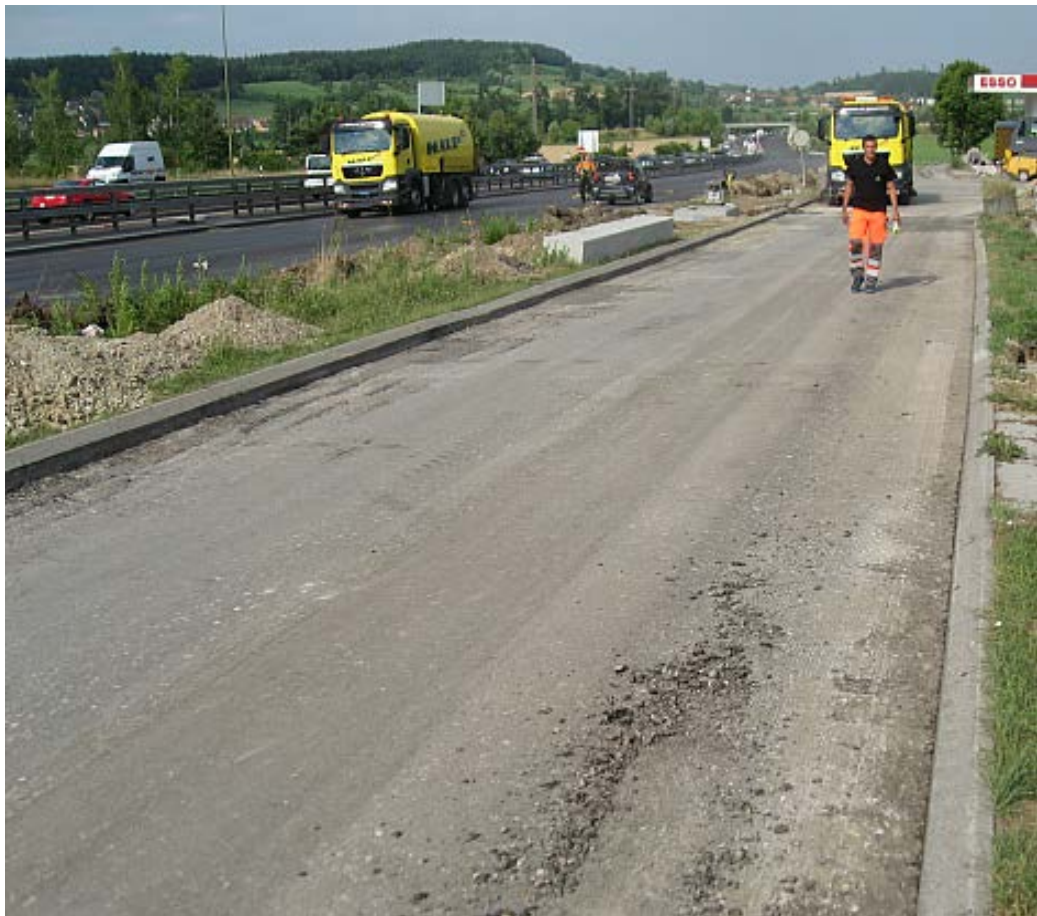
Abb. 43 Nass- und Trockenreinigung der Fräsfläche des bestehenden Belages.
