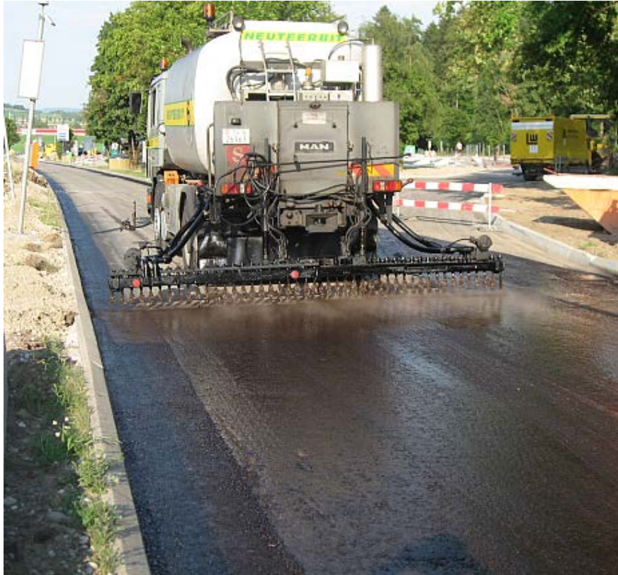
Abb. 46 Applikation Emulsion auf Fräsflächen.
