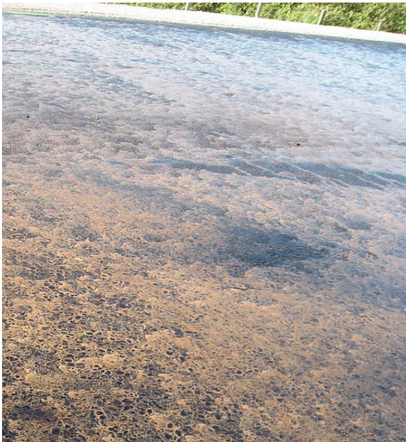
Abb.9 Spezielles wellenförmiges Spritzbild des Haftklebers HCP nach der Applikation.
