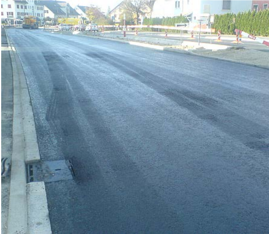
Abb. 38 Haftkleberoberfläche mit LKW - Radsuren.
