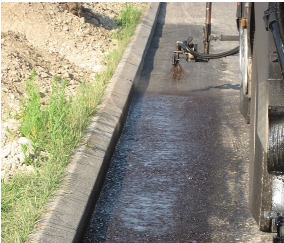
Abb. 45 Vorarbeiten Applikation der Emulsion entlang Randabschlüssen (optimaler noch mit Schutzführungsblech gegen Randabschuss).
