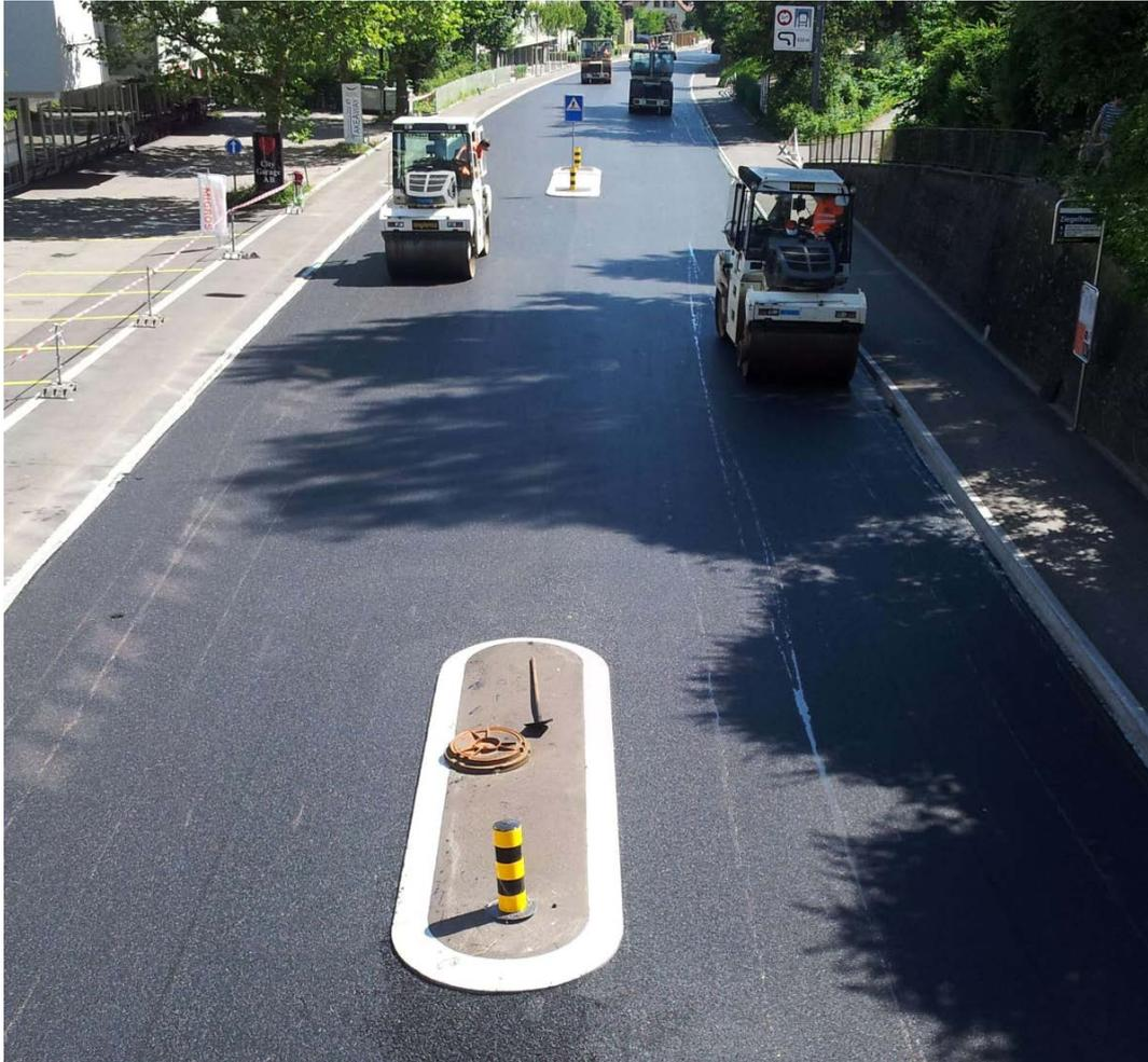
**Abb. A 5** Dynamische (Vordergrund) und statische Walzen (Hintergrund) im Einsatz.
