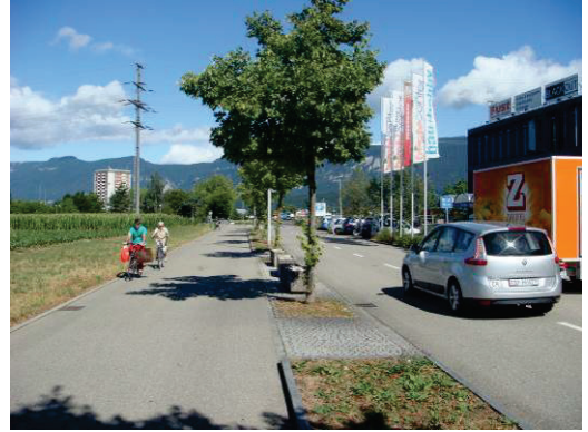
Abb. 75: A2, Waldeggstrasse, Gemeinsamer Rad- und Fussweg, Zuchwil
