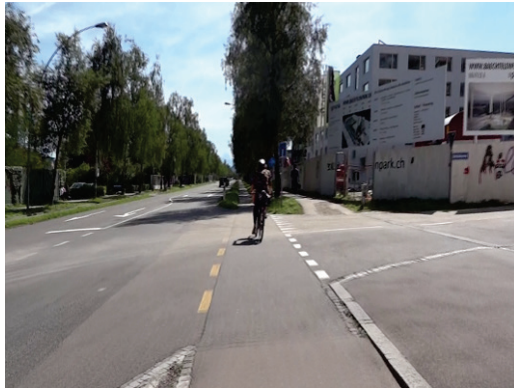
Abb. 122: A2, Rad- und Fussweg mit getrennten Verkehrsflächen, Fahrtrichtung Kehrsatz
