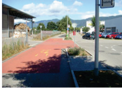
Abb. 21 Einfahrt zu Industriebetrieb: Veloschnellroute durchgezogen ergibt eine klare Vortrittsregelung
