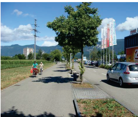
Abb. 180: (Zweirichtungs-) Rad- und Fussweg, Solothurn-Wasseramt A2
