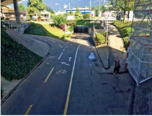
Abb. 80: K2, Unterführung auf Rad- und Fussweg mit getrennten Verkehrsflächen, Zuchwil
