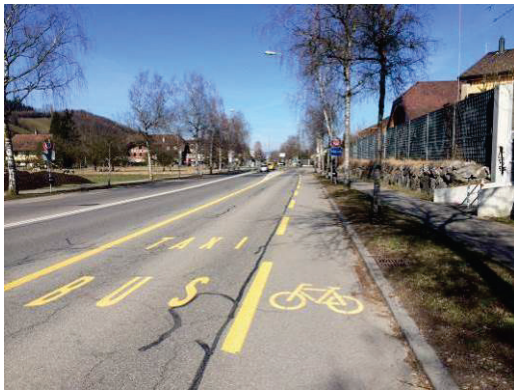
Abb. 116: A1, Busstreifen und Radstreifen, Fahrtrichtung Bern
