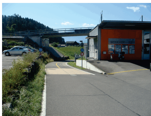
Abb. 46: Übergang Bahnhofstrasse / Zweirichtungsradweg, Heimberg*
