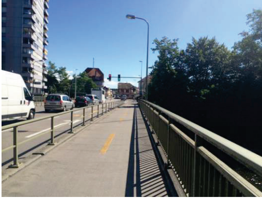
Abb. 74: * Emmebrücke, Gemeinsamer Rad- und Fussweg, Derendingen
