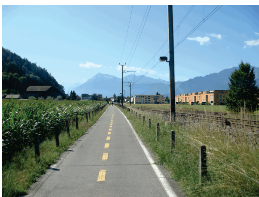
Abb. 45: Zweirichtungsradweg Heimberg höhe Grabehüsibach*
