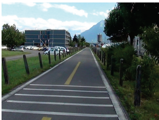
Abb. 41: A2, Zweirichtungsradweg ohne Fussgängerführung
