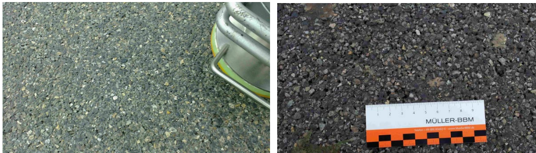
Abb. 40 Detailfotos von der Deckschicht SDA 8C in Fulenbach (links, mit Messfuss der Strömungswiderstandsapparatur) und SDA 6B in Kestenholz (rechts).
