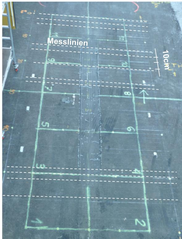
Abb. 15 Messgitter für die Inspektion des Belags mit Georadar
