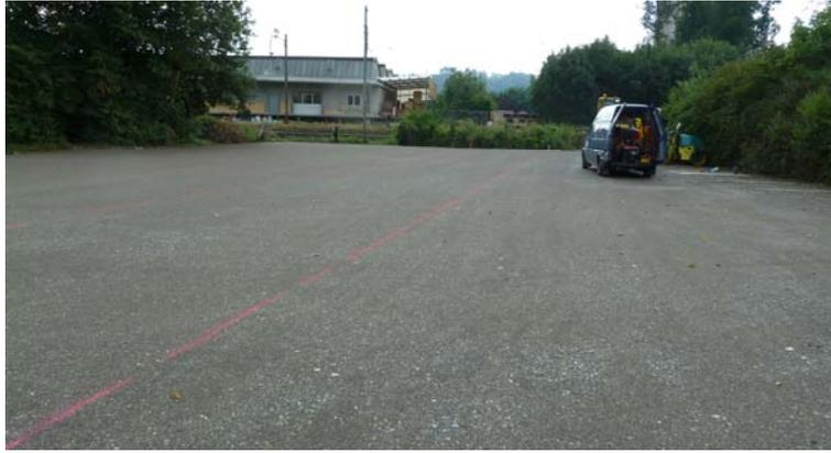
**Abb. 3** Erstellte Planie des Testgeländes
