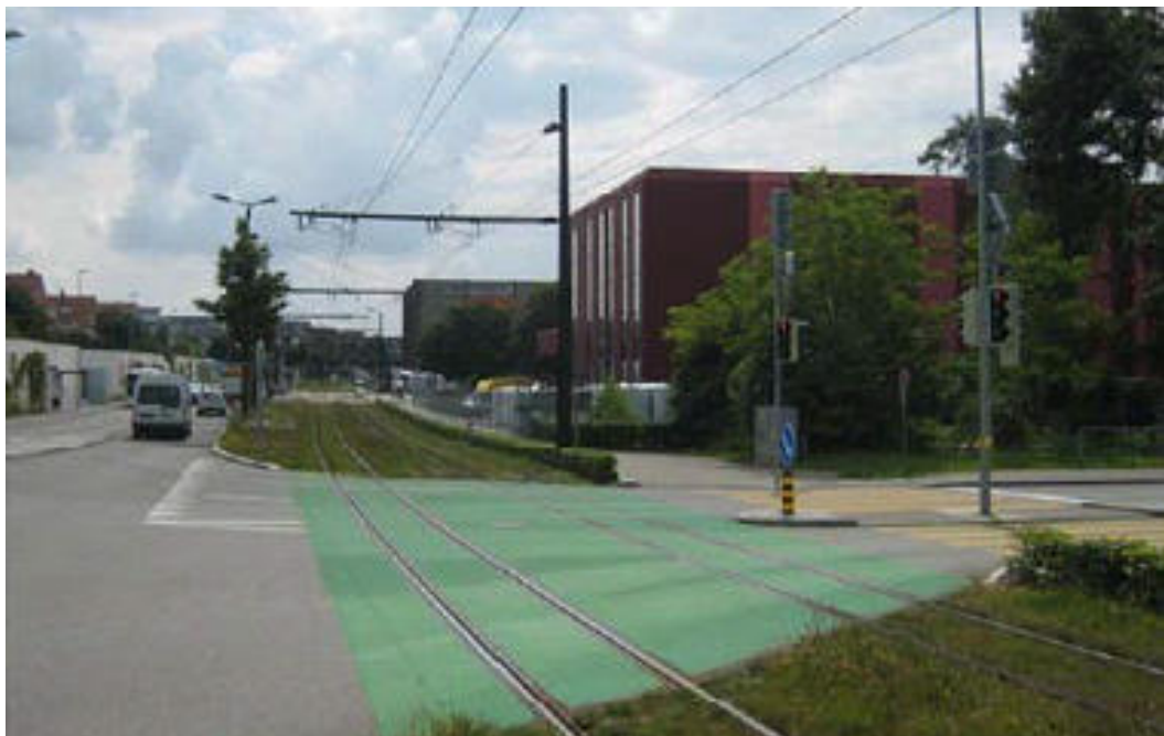
Abb.33 Einfärbung des Strassenbahntrassees in gelbgrüner Farbe (RAL 6018) T-Knoten West-/Hertistrasse (Wallisellen, Verkehrsbetriebe Glattal, 685'917 252'396) [Bild: © tribus verkehrsplanungs ag]
