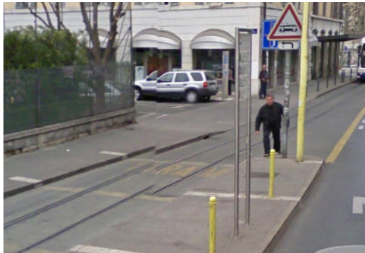
Abb.44 Warnsignal Strassenbahn als Wechselblinker (Genf, bei Haltestelle 499'895 118'180)
