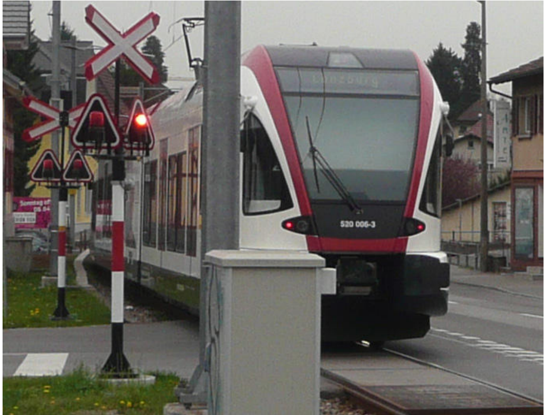
Abb.46 Drehwarnblinker, der nach LSA-Technik funktioniert (Seon, Knoten Seetal-/Talstrasse, SBB (Seetalbahn), 654'417 244'394) [Bild: 2014]
