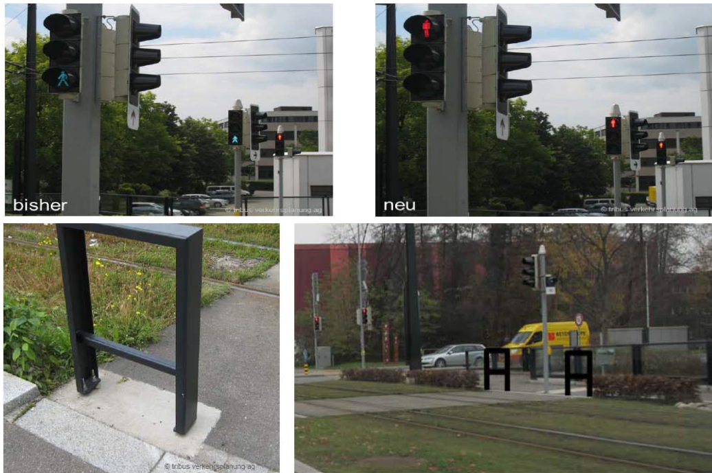
Abb.15 Verriegelung Fussgängerfolgequerung (oben), Abschränkungen zur Einengung des Übergangs (unten). Übergang beim T-Knoten West-/Hertistrasse (Wallisellen, Verkehrsbetriebe Glattal, 685'917 252'396). [Bilder: © tribus verkehrsplanung ag]
