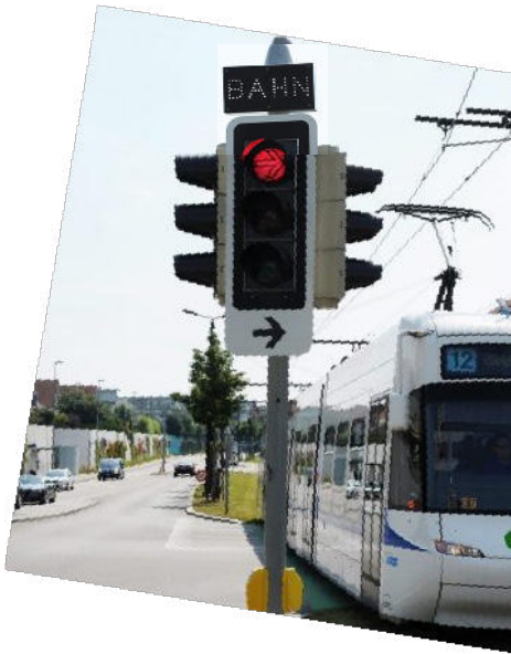
Abb.47 LED-Signal „BAHN“, T-Knoten West-/Hertistrasse (Wallisellen, Verkehrsbetriebe Glattal, 685'917 252'396) [Bild: Keystone/Steffen Schmidt]
