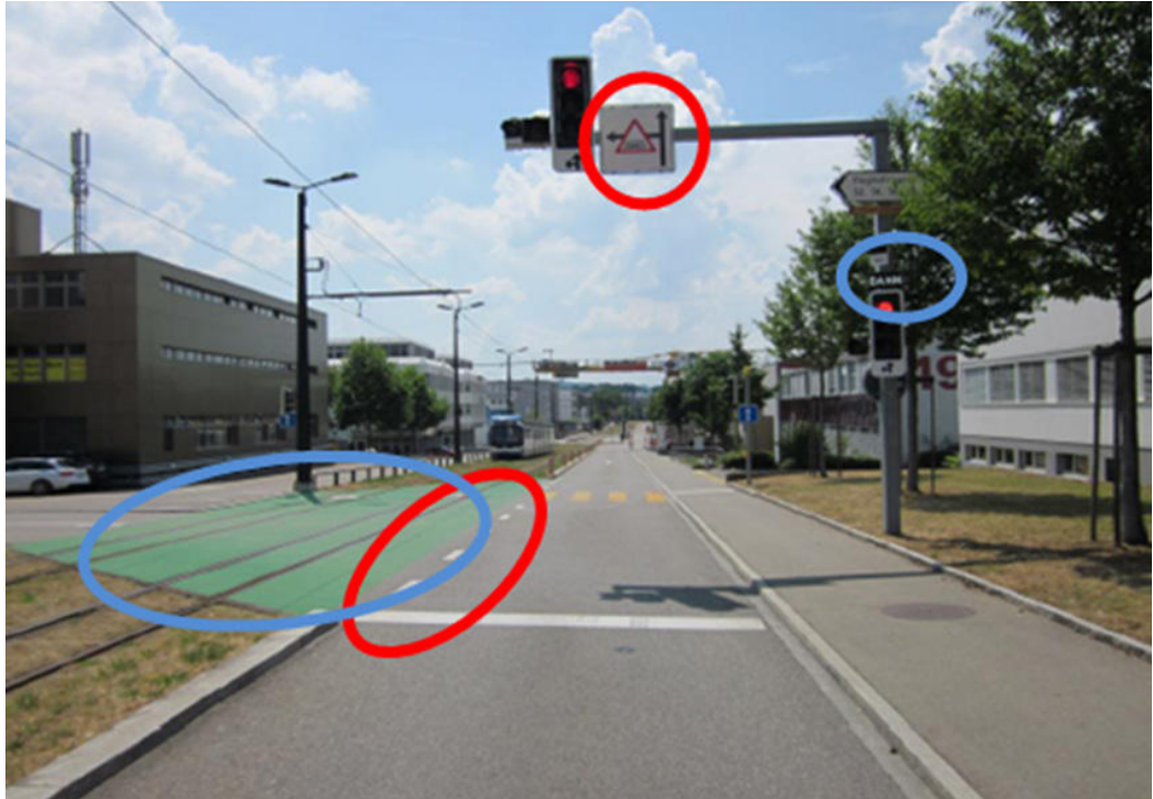
Abb.32 Gegenmassnahmen zu den Unfällen bei der Glattalbahn am Knoten Flughafen-/ Riethofstrasse (Opfikon, Verkehrsbetriebe Glattal, 684'914 254'857). Die zunächst getroffenen Massnahmen sind durch rote Ovale gekennzeichnet. Mitte 2013 wurden weitere Massnahmen ergänzt; blaue Ovale [Bild: Juli 2013 Verkehrsbetriebe Glattal]
