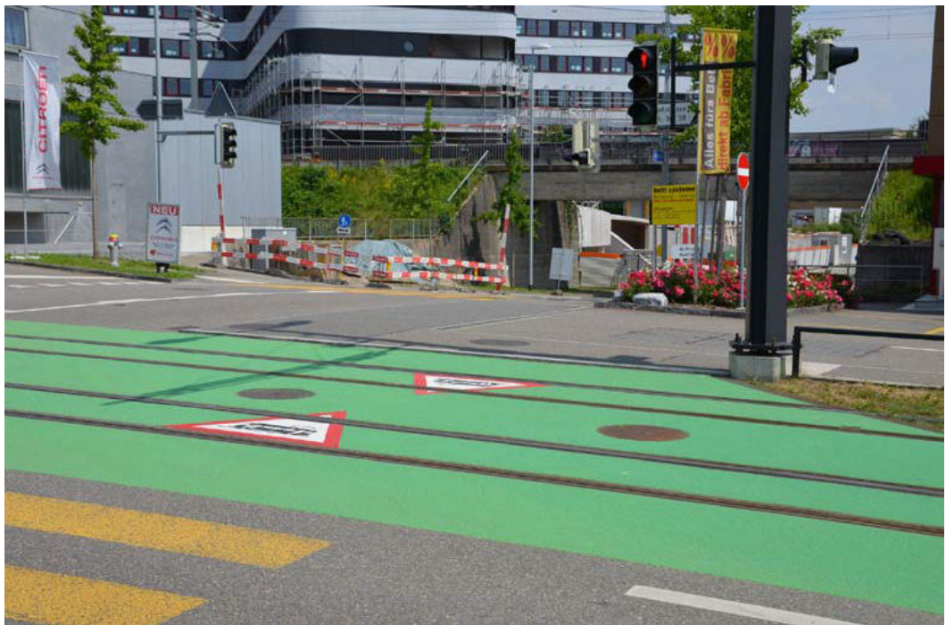
Abb.18 Warnsignal Strassenbahn (1.18) teilweise auf dem Boden im Bereich der Fussgängerquerung zusammen mit der Einfärbung des Strassenbahntrassees in gelbgrüner Farbe markiert. Knoten Flughafen- /Riethofstrasse (Opfikon, Verkehrsbetriebe Glattal, 684'914 254'857). [Bild: Juli 2013 Verkehrsbetriebe Glattal]
