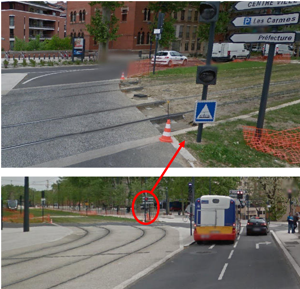
Abb.39 Zusätzlicher roter Wechselblinker zum Rotlicht in Frankreich (R24 – Signal d'arrêt), rechts vor Gleisquerung (Toulouse, Allée Paul Feuga/ Boulevard du Maréchal). [Bilder: © 2014 Google, Juni 2014, Google Street View]
