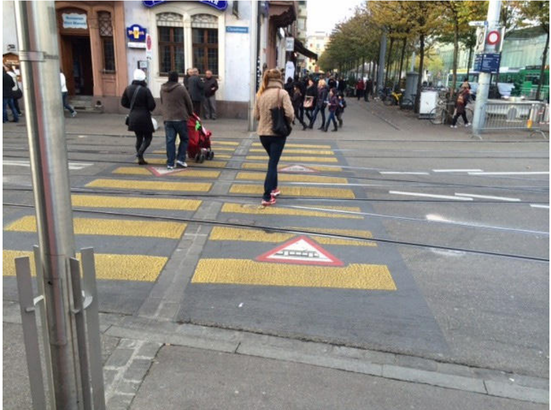
Abb.17 Warnsignal Strassenbahn (1.18) an Fussgängerquerungen über die gelben Querstreifen markiert. Basel, Basler Verkehrsbetriebe
