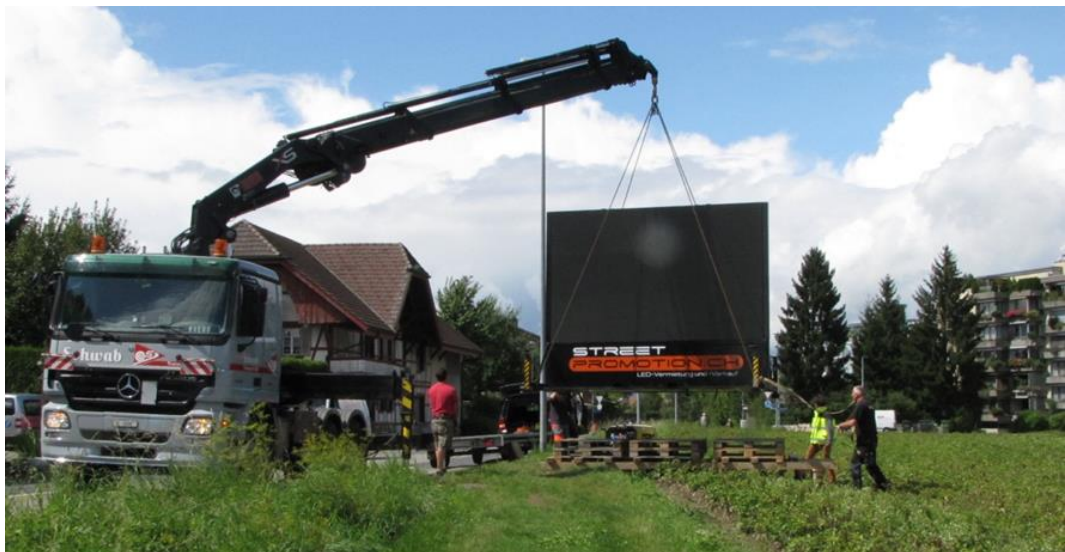
Abb. 13: Montage der LED-Tafel
