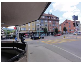
Unterführung mit Einschränkungen
