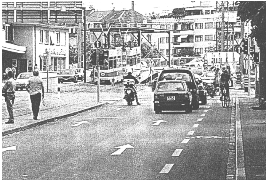
Abb. 24: Münchensteinerstrasse in Basel Überbreite Fahrspur (5.3m), Radstreifen (1.2m) Quelle: Velostadt Basel, 1995, Lit.[9]
