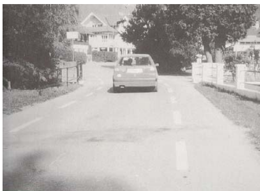
Abb. 9: Mit Leitlinien markierter Mehrzweckstreifen (etwa 1.1m breit) auf einer nur 5m breiten Fahrbahn (Lochau, A); Quelle: Lit. [36]
