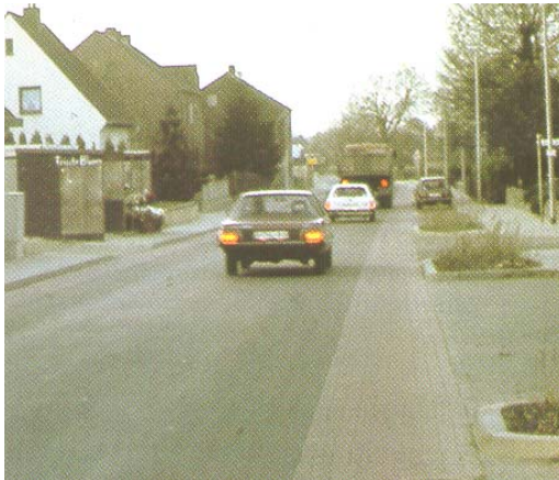
Abb. 8: Suggestivstreifen mit baulich differenziertem Belag drängen den Kraftverkehr zur Fahrbahnmitte – Schutzraum für Radfahrer; Quelle: Lit. [29]
